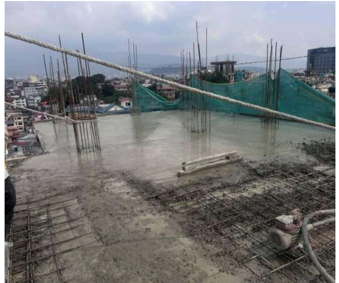
SLAB POUR • KATHMANDU
