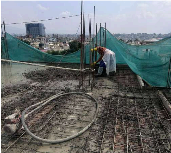
SLAB POUR • KATHMANDU
